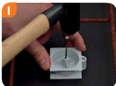
1 Dolną część przybić do szalunku
