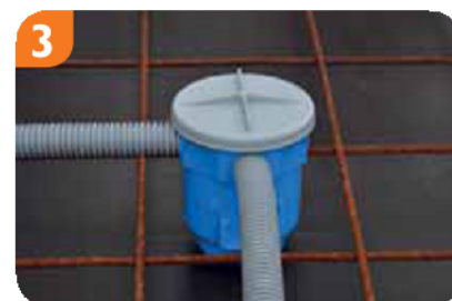
3 Montaż w wersji sufitowej
