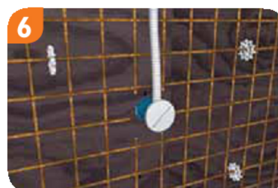
Włożyć rury i w zależności od potrzeb wykorzystać jako puszkę osprzętową lub rozdzielczą
