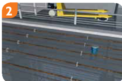
2 Ułożenie siatki zbrojeniowej
