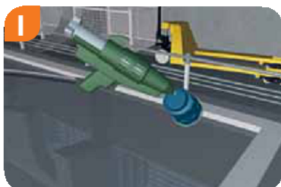
1 Zamocowanie puszki pistoletem klejowym na stole szalunkowym
