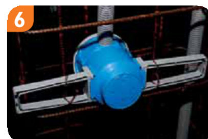
6 Montaż ze skrzydłami mocującymi na zbrojeniu
