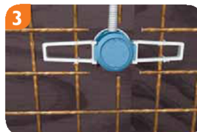
Montaż ze skrzydłami na zbrojeniu (Puszka osprzętowa)
